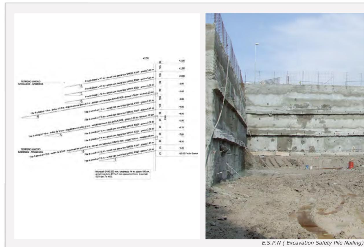
**E.S.P.N. (Excavation Safety Pile Nailing) :** parete chiodata abbinata a micropali verticali radi, sistema di consolidamento "ibrido" in grado di raggiungere alte profondità di scavo anche con edifici a confine ed in tempi più brevi rispetto la tradizionale berlinese di micropali e tiranti.
